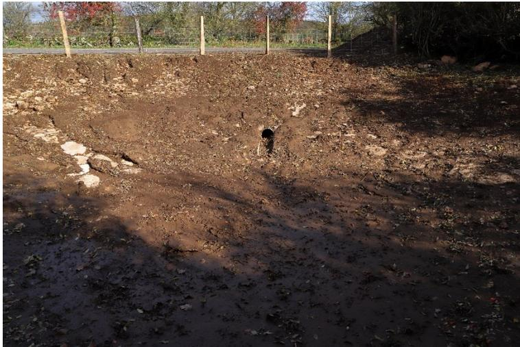
*Figure 47 : Après travaux, drain dans le flanc de la lavogne ne permettant pas la remise en eau, PNRGC, novembre 2021*
