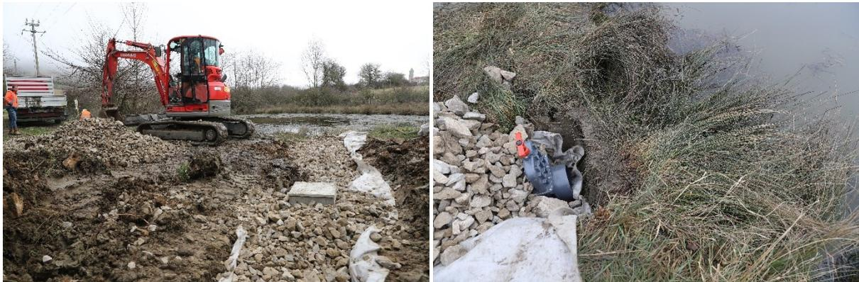
*Figure 61 : Pose du drain réversible, PNRGC, février 2024*
